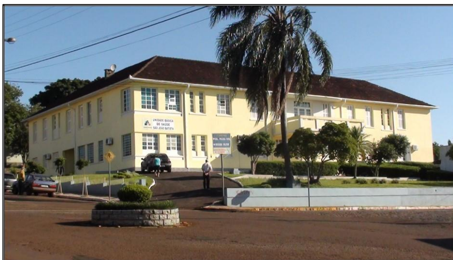
Figura 3. Locais importantes no município de Colorado, RS. A) Igreja Matriz; B) Prefeitura Municipal; C) Praça Central Municipal; D) Museu municipal; E) Antigo hospital municipal São João Batista, hoje Unidade Básica de Saúde; F) Fonte: Setor de Comunicação da Prefeitura Municipal.
