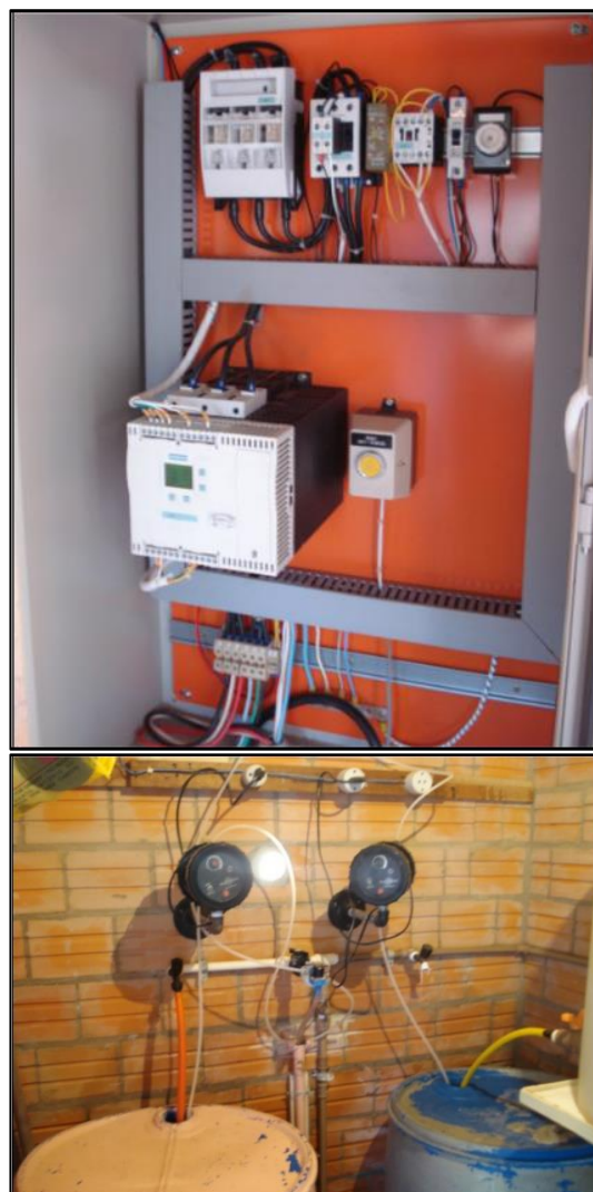
Figura 22. Imagem interna do quadro de comandos (A) e reservatório de Cloro e Fluor (B).
