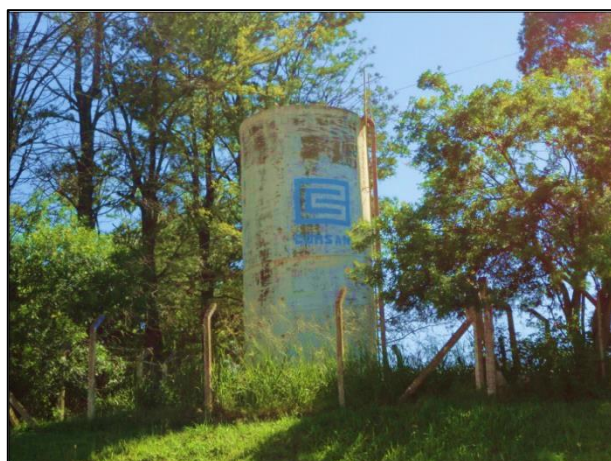
Figura 25. Reservatório Elevado de Fibra de Vidro R-1. Fonte: Vigilância Sanitária Municipal (2013).
