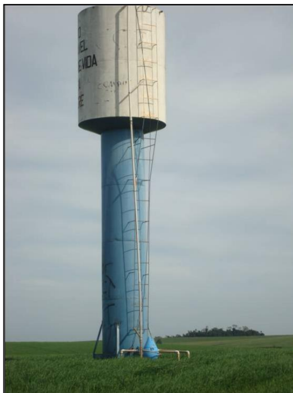
Figura 29. Poços tubulares existentes em Colorado. Linha Raspa, abastece 29 propriedades.
